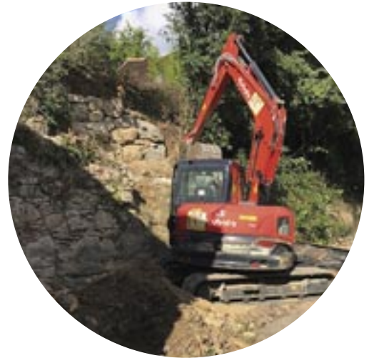
▲ Enrochement à Rouvenac chemin de Toziels
